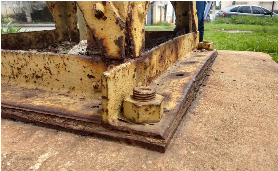
**Figura 47** Detalhe da base da estrutura oxidada da caixa d'água próxima ao Galpão da Estação Ferroviária Santa Luzia, Praça Getúlio Vargas, São João Batista – Santa Luzia/MG. Foto: Rodrigo Leite – 10/12/19.
