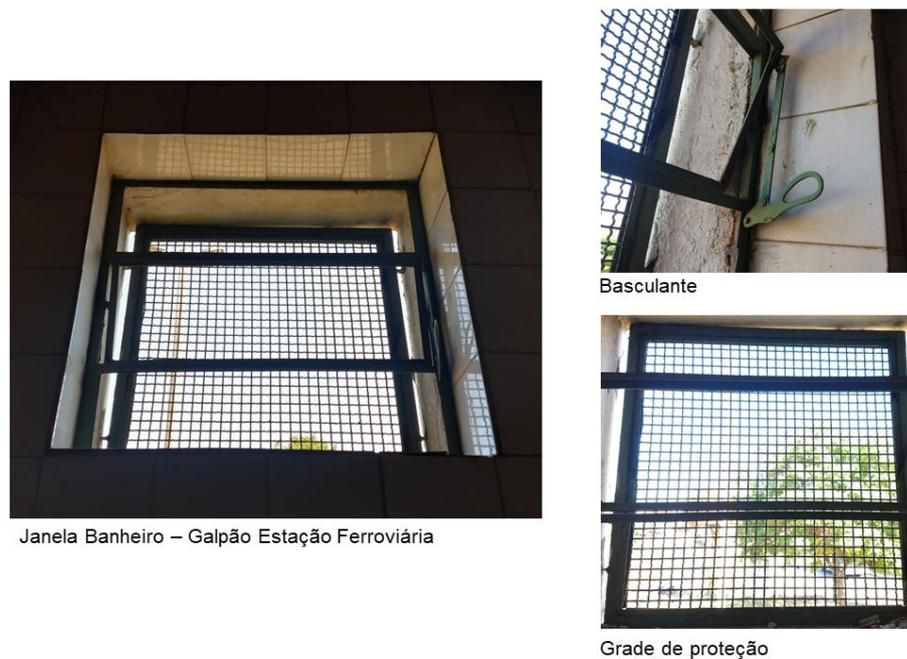
**Figura 97** Detalhe ferragem da janela do banheiro (Tipo) do galpão da Estação Ferroviária. Fonte: Rodrigo Leite, 2019.
