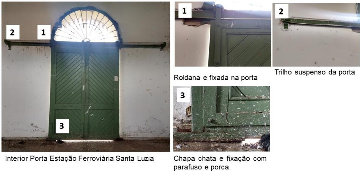
**Figura 89** Detalhe das ferragens internas da Estação Ferroviária. Fonte: Rodrigo Leite, 2019.
