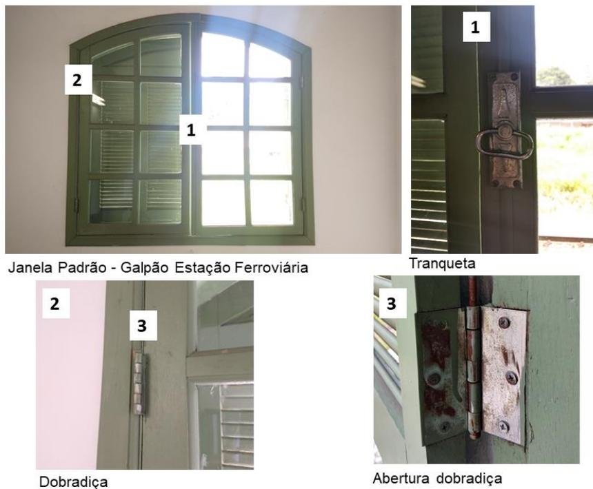
**Figura 96** Detalhe ferragem da janela do tipo 1 do galpão da Estação Ferroviária. Fonte: Rodrigo Leite, 2019.
