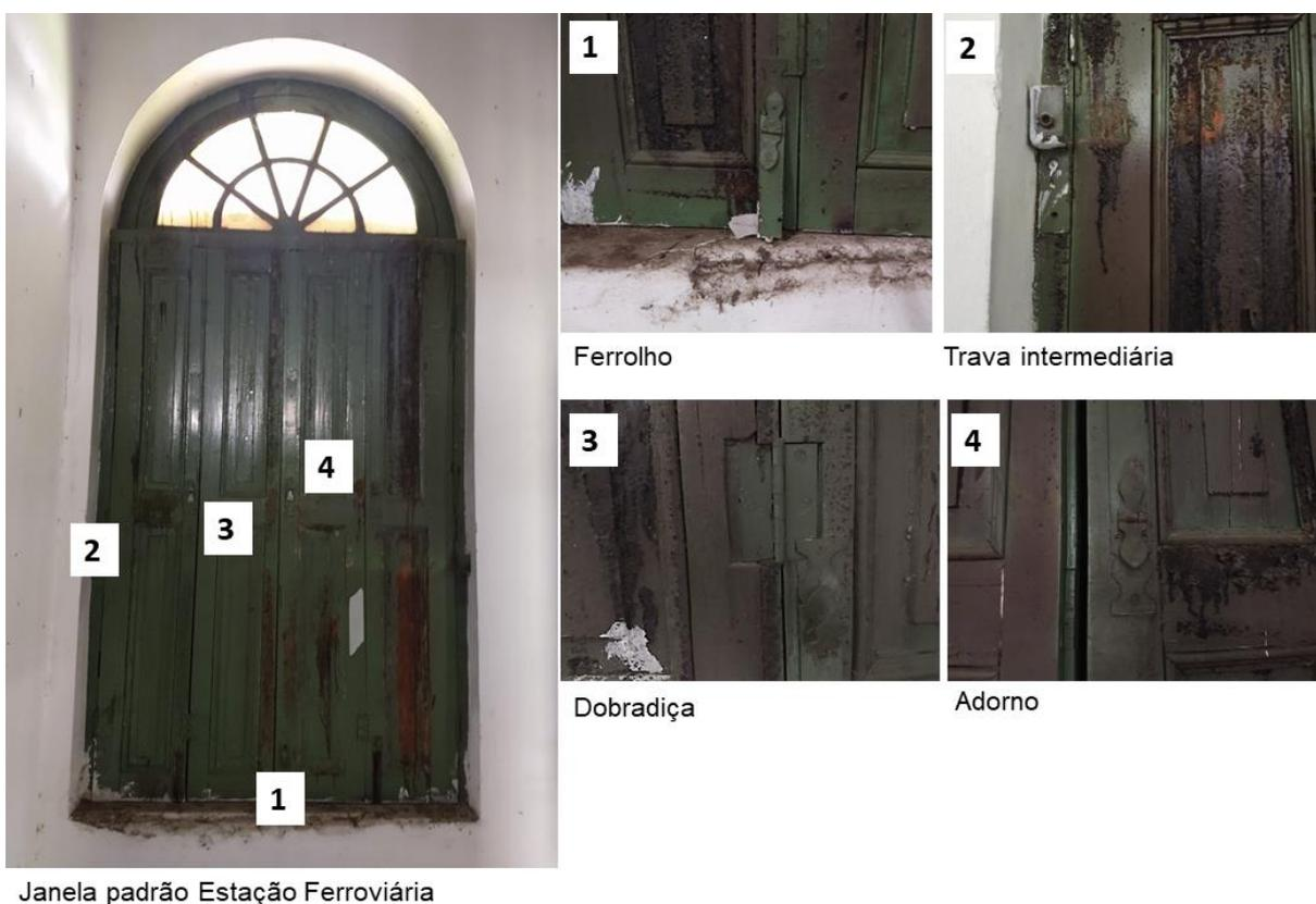
**Figura 90** Detalhe das ferragens da janela da Estação Ferroviária. Fonte: Rodrigo Leite, 2019.
