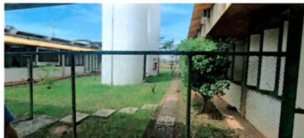
Figura 25. Área externa, reservatórios.
