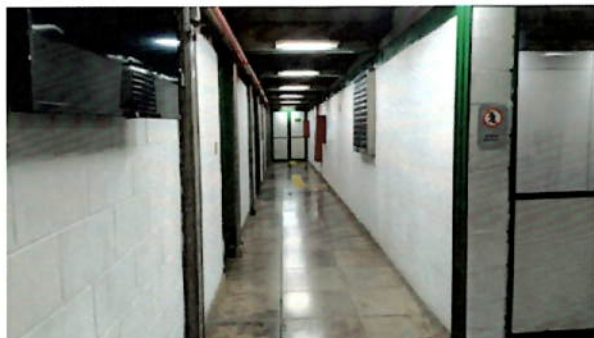
Figura 17. Área de circulação.
