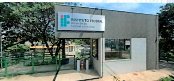
Figura 5. Guarita acesso pedestres.
