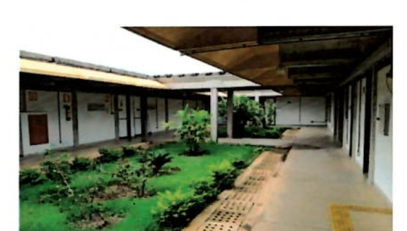
Figura 64. Área Interna Bloco C
