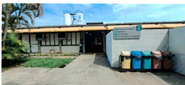
Figura 12. Bloco A, acesso.
