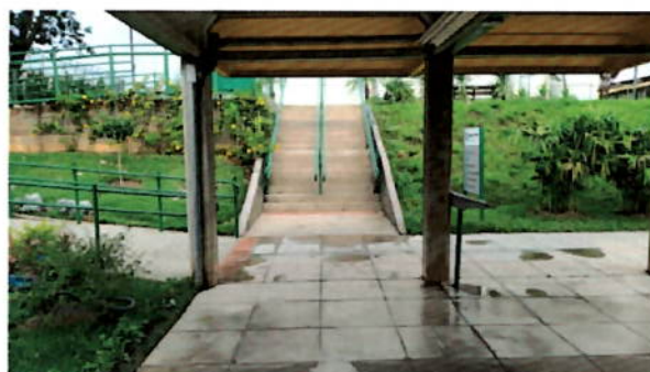
Figura 58. Circulação externa acesso Bloco C.
