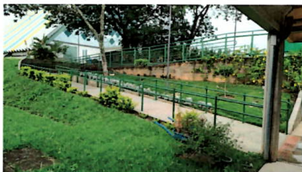
Figura 57. Circulação externa acesso acessível Bloco C.
