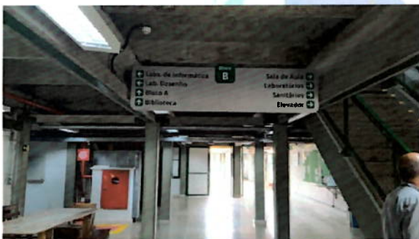
Figura 45. Bloco B. Área de circulação.
