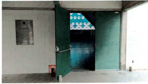
Figura 48. Acesso quadra poliesportiva.
