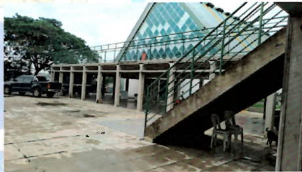
Figura 46. Área de circulação externa. Pátio.
