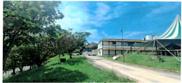
Figura 74. Visada Área externa.
