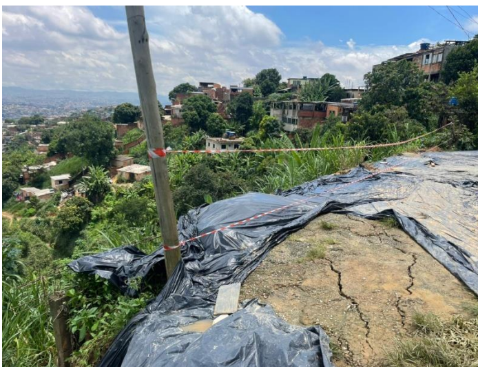
10 - Deslizamento de talude na Rua 28 de Fevereiro Bairro Vila Nova Esperança (remoção de aproximadamente 7 famílias);
